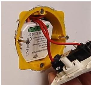
Ce module est encastrable dans une boîte de 50 mm de profondeur
